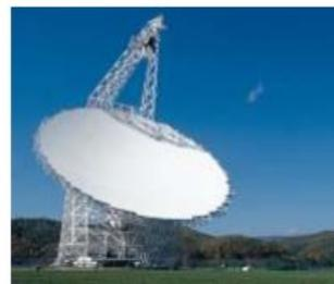
Le Green Bank Telescope (GBT) (États-Unis) est un radiotélescope de 110 m de diamètre qui permet de capter des photons invisibles pour nos yeux. Le rayonnement radio s'étend du millimètre au kilomètre. À titre d'exemple, le GBT est sensible aux ondes de longueur d'onde de 10 cm, comme celles utilisées pour les téléphones portables. C'est pour cette raison qu'il est interdit d'utiliser un téléphone portable (ou même un four micro-onde) dans un environnement proche du GBT.
